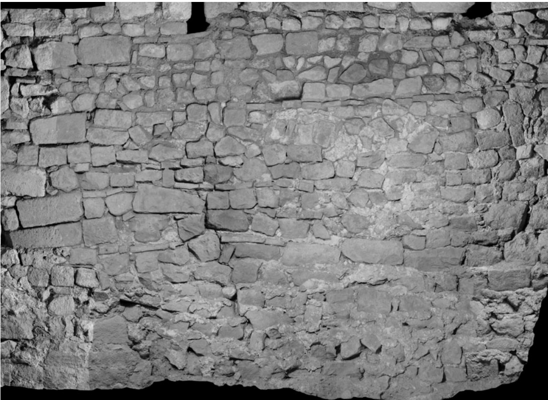
Figura 17 Vista externa del cierre posterior de Centcelles. Se puede apreciar el uso del ladrillo, así como también de la presencia de los mechinales. [Fotografía: Jordi López]
