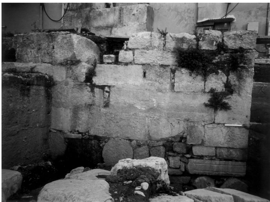
Figura 14 Paramento hecho con sillares reutilizados, columnas y otros elementos de expolio. La Almoína de Valencia, Siglo VI. [Fotografía: Julia Beltrán]
