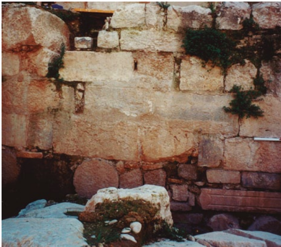
Figura 14 Paramento hecho con sillares reutilizados, columnas y otros elementos de expolio. La Almoina de Valencia. Siglo VI. [Fotografía: J. Beltrán]
