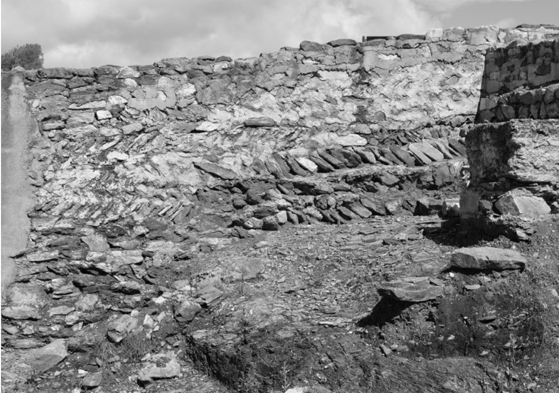
Figura 9 Detalle de un paramento con tramadas en opus spicatum . Castellum de Sant Julià de Ramis, Girona, siglo VI. [Fotografía: Josep Maria Macias]
