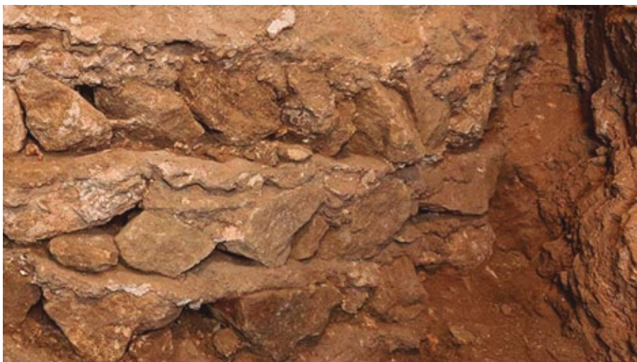
Figura 9 Detalle de un paramento con tramadas en opus spicatum . Castellum de Sant Julià de Ramis, Girona. [Fotografía: J. M. Macias]
