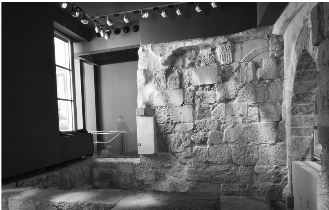
Figura 1 Paramento realizado en su totalidad con material de spolia . Destacan los grandes sillares, las columnas y otros elementos arquitectónicos decorados. La Almoína de Valencia. Siglo VI. [Fotografía: Josep Maria Macias]
