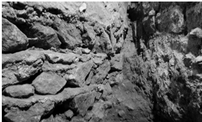
Figura 8 Detalle del opus spicatum de la cimentación de la Basílica dels Sants Màrtirs Just i Pastor de Barcelona, siglo VI. Se pueden ver las hiladas anchas y los lechos de mortero con las juntas salientes. [Fotografía: Pere Vivas-Parroquia Sants Just i Pastor]
