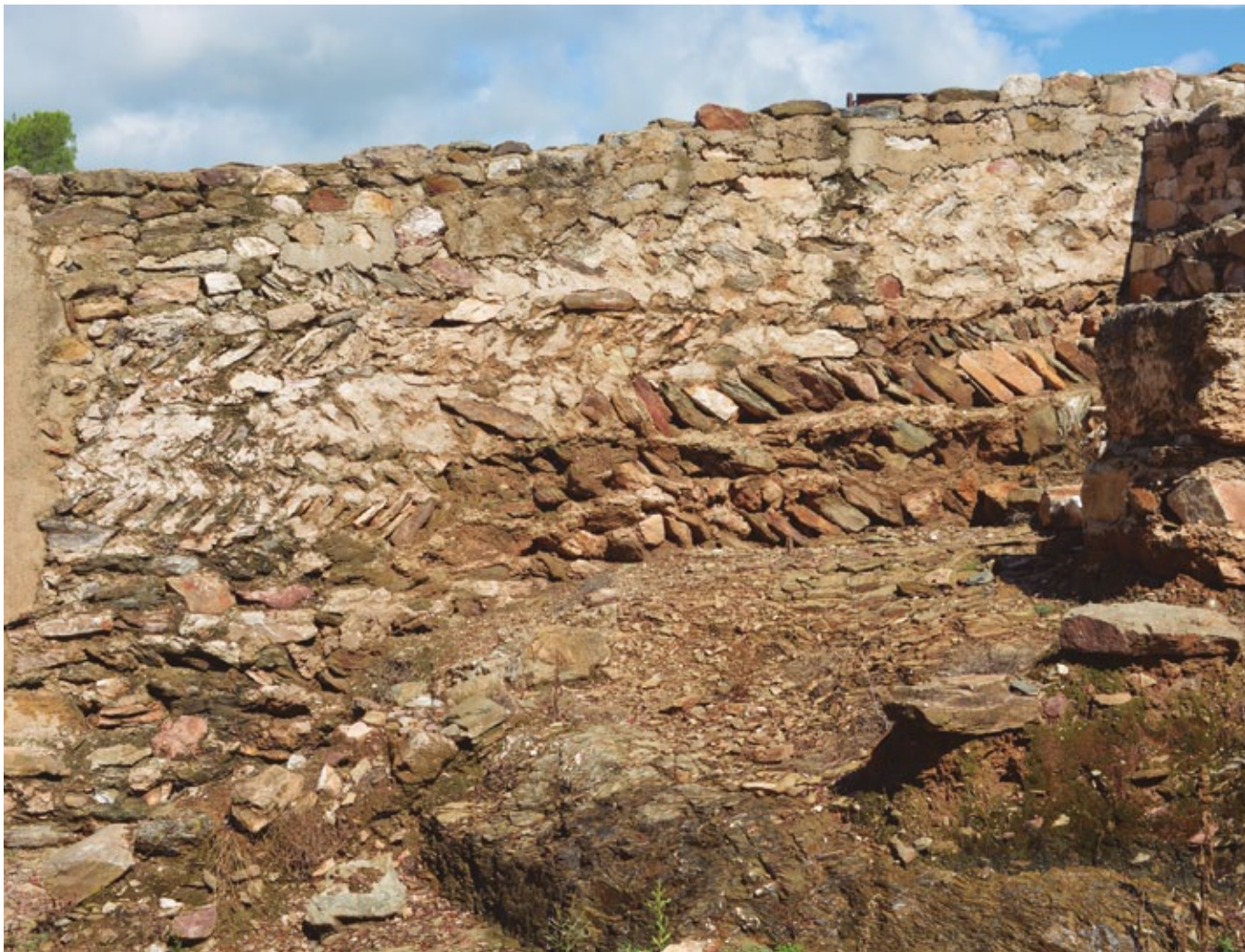
Figura 9 Detalle de un paramento con tramadas en opus spicatum . Castellum de Sant Julià de Ramis, Girona. [Fotografía: J. M. Macias]
