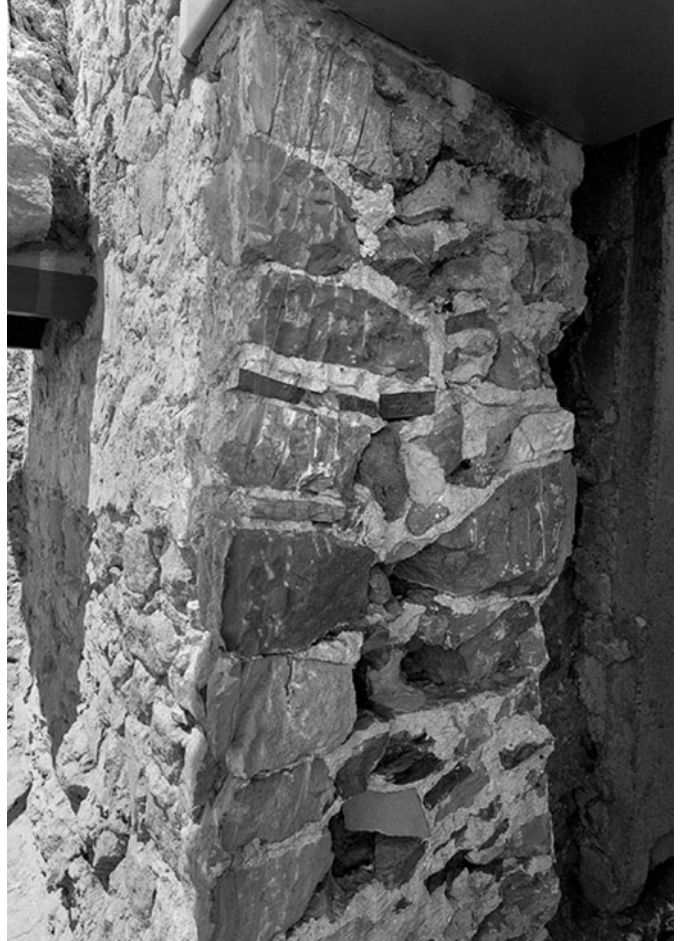
Figura 7 Muro de composición tripartita de las construcciones del palacio del obispo del siglo VI (subsuelo arqueológico de Plaza del Rey de Barcelona). Se pueden ver la disposición de los forros exteriores y del relleno en bruto interior, así como los diferentes lechos de mortero. [Fotografía: Pere Vivas-MUHBA]
