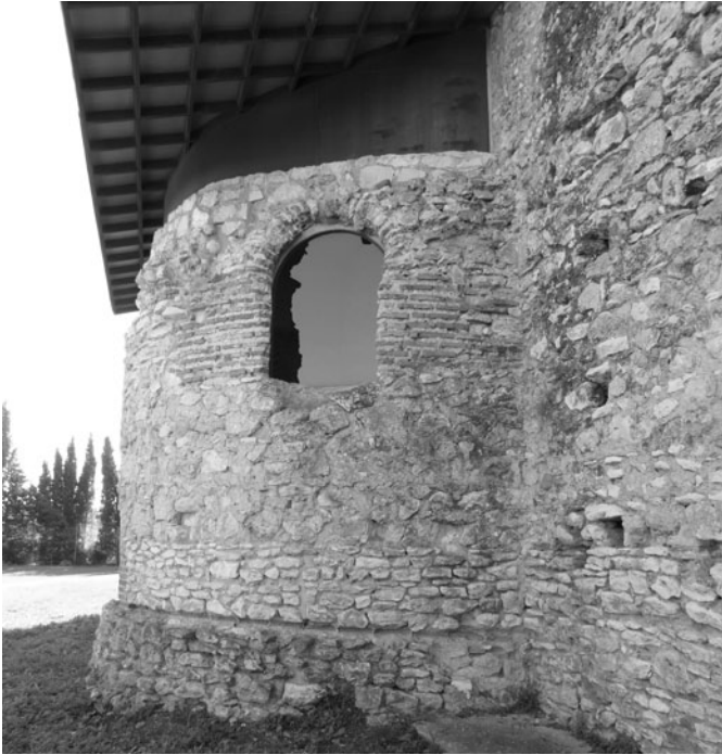
Figura 17 Vista externa del cierre posterior de Centcelles. Se puede apreciar el uso del ladrillo, así como también de la presencia de los mechinales. [Fotografía: Jordi López]
