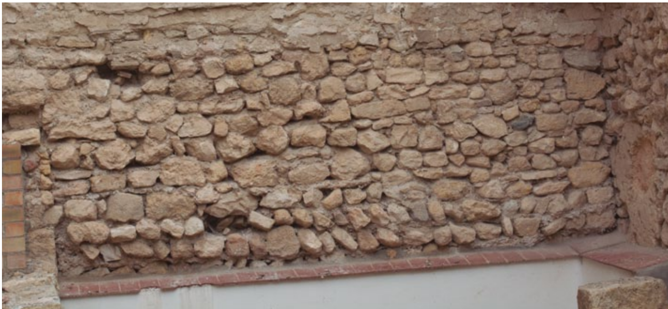
Figura 24 Paramento con presencia de opus spicatum de los siglos V-VI. Tarragona. [Fotografía: J.M. Macias]
